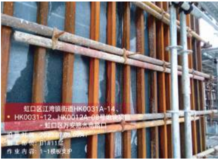
镀锌方管加固硅墨烯
